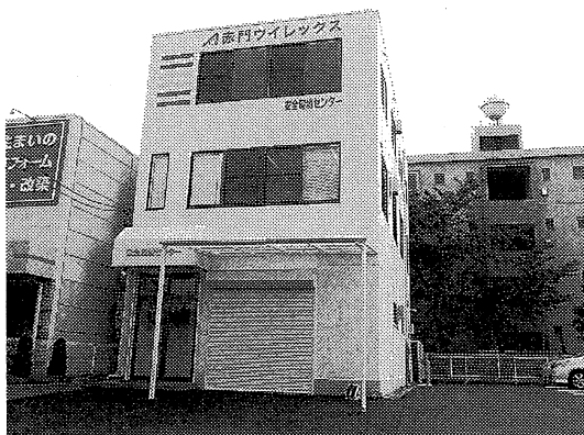
新設した「安全環境センター」(長久手市戸田谷)
