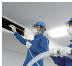
ダクト清掃 (IAQ工法)
