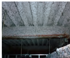
アスベスト含有吹付け材除去例
